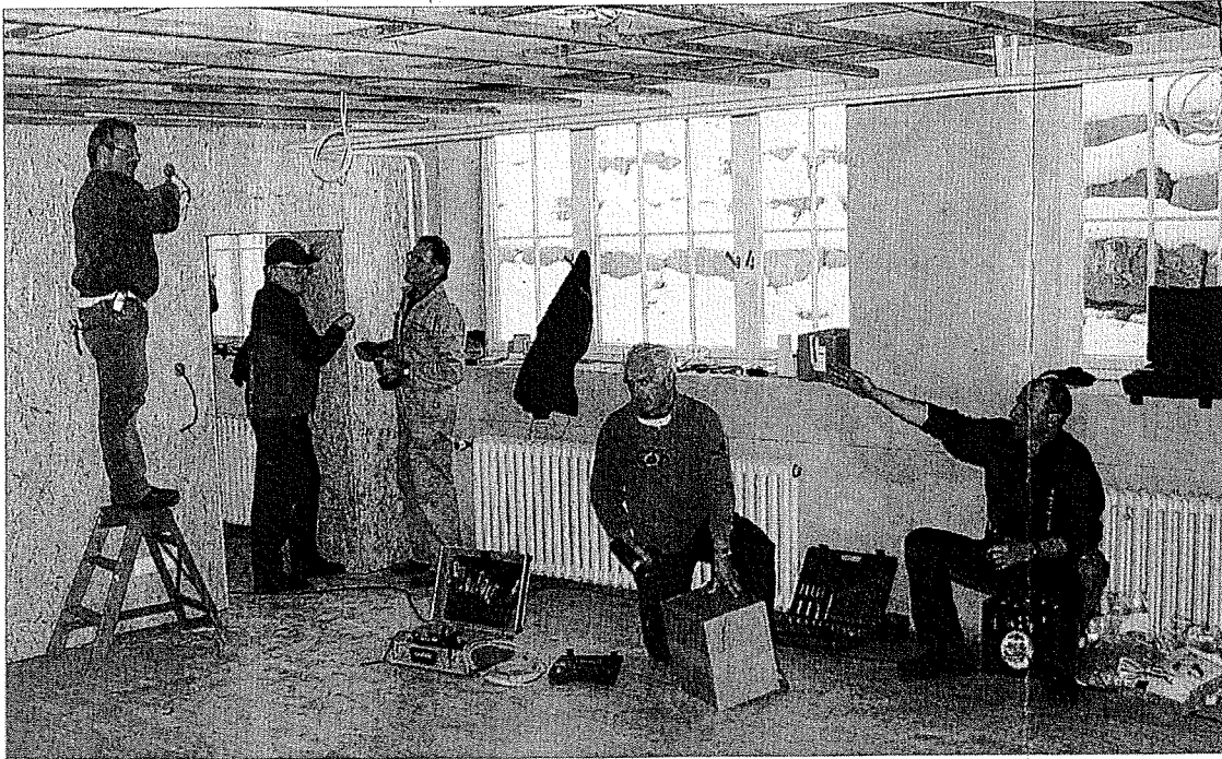
Im Keller der Münsinger Schillerschule entsteht derzeit ein Traditionsraum des ehemaligen Panzerartilleriebataillons 285. Derzeit wird fleißig gewerkelt. Foto: Joachim Lenk
